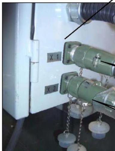
Подключите провод питания насоса для подачи охлаждающей жидкости и масляного насоса к электрощкафу.
